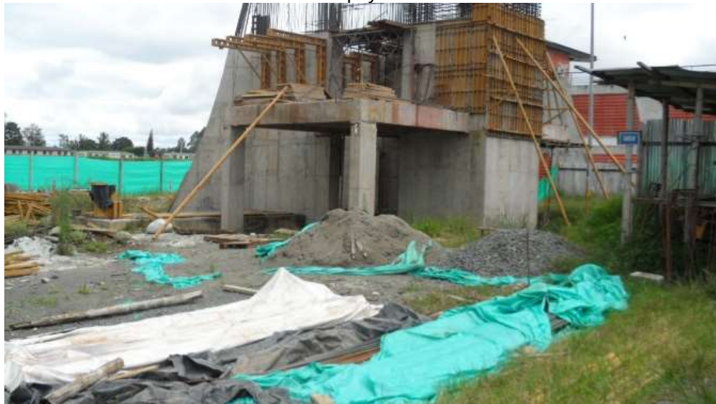
Imagen 30 Foto de las obras de la Torre de Control del Aeropuerto Guillermo León Valencia de Popayán.
