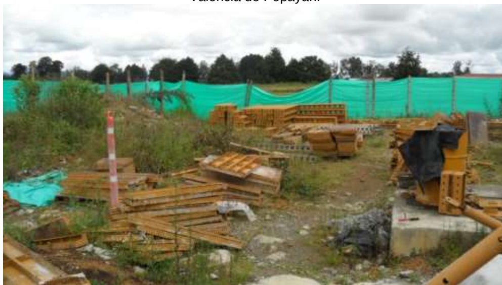
Imagen 31 Foto del Interior de las obras de la Torre de Control del Aeropuerto Guillermo León Valencia de Popayán.
