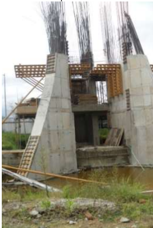
Imagen 32 Vista lateral del proceso constructivo sin desencofrar.
